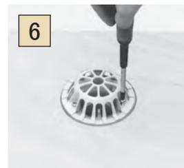
6 カバー取付用ネジをはずし、ドレインカバーをセットし3本のネジで取付けて完了。
