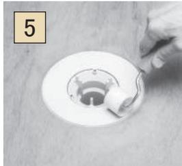
ハンドローラーで補強シートをパネルに圧着する。
