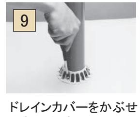
ドレインカバーをかぶせ3本のネジで取付けて完了。
