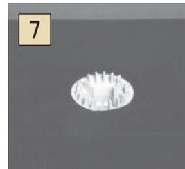
防水シートにφ130の穴を開け補強シート上部に接着剤を塗り防水シートに圧着する。
