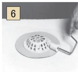
ハンドローラーで補強シートをALCに圧着する。
