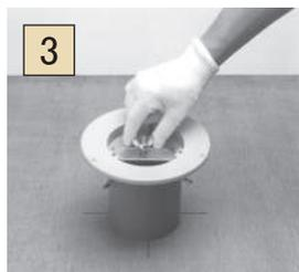
3 ドレイン本体にLアンカーを取り付けます。ドレイン本体を置き、固定プレート、蝶ナットで固定してください。
