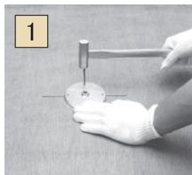
1 ドレイン施工位置を決める。型枠に十字線を引き、十字線の中心に10mm程の穴を開けます。位置決めプレートを十字線の中心と合わせ、釘で打ち付けて固定してください。
