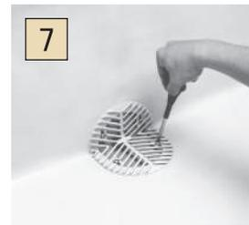
ドレインカバーをかぶせ4本のネジで取付ける。
