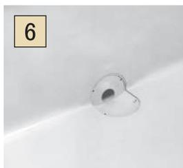
防水シートに穴を開け補強シート上部に接着剤を塗り防水シートに圧着する。
