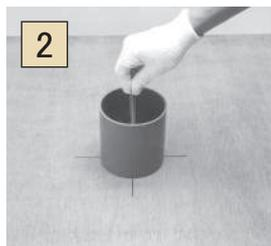
2 スペースを置き、長ネジを位置決めプレートにねじ込んでください。長ネジはドレイン本体上面より高くないようにねじ込みます。
