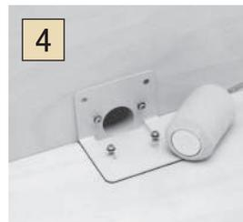
ドレイン本体のカバー取付ネジを最後まで締めつける。ドレイン本体のサンディング部分にプライマーを塗る。
