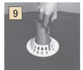
ドレインカバーをかぶせ3本のネジで取付けて完了。
