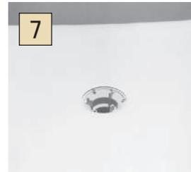
防水シートに穴を開け補強シート上部に接着剤を塗り防水シートを圧着する。
