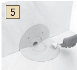
ハンドローラーで補強シートを圧着する。
