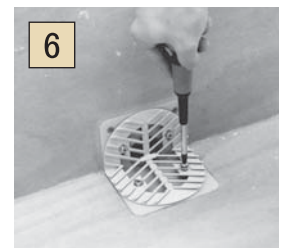
カバー取付用ネジをはずし、ドレインカバーをセットし4本のネジで取付けて完了。
