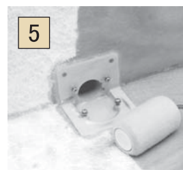
ガラスマットを置きFRP樹脂を塗布し固まるまで待つ。
